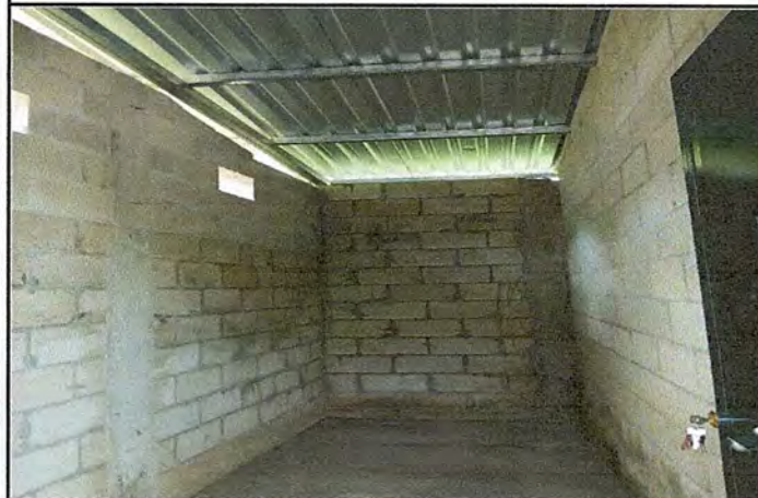
Foto 3: MEJORAMIENTO E INSTALACION DE TECHO DE COCINA, PISO Y PUERTA
