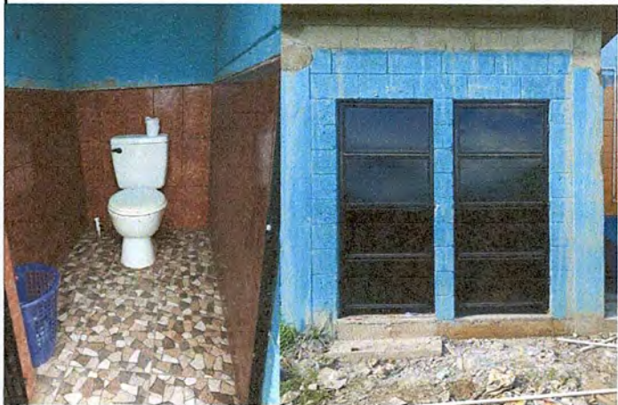
Foto 4: REMOZAMIENTO DE BAÑOS, PUERTA, PINTURA Y PISO
