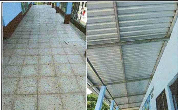
Foto 2: MEJORAMIENTO E INSTALACION CAMBIO DE TECHO Y PISO
