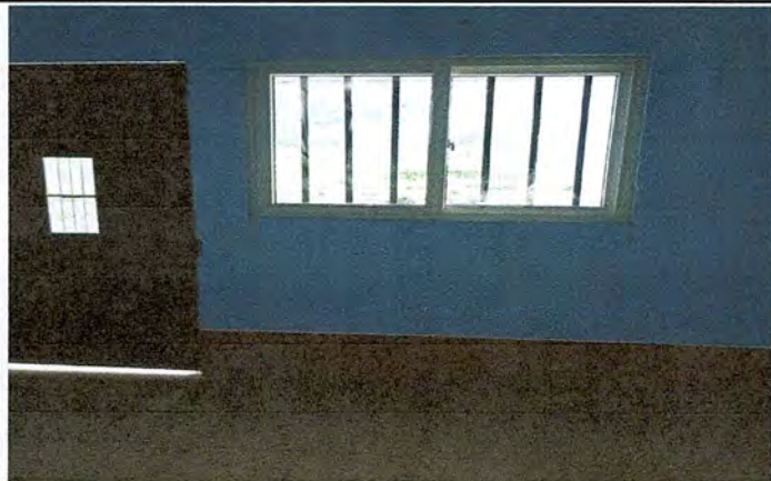
Foto 1: MEJORAMIENTO E INSTALACION DE VENTANAS DE PVC
